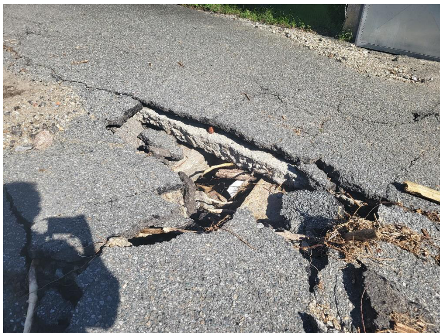
Cedimento del tombamento visto dalla superficie stradale.
